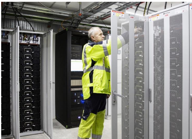
Batteriet er opdelt i 70 mindre sektioner, som tilsammen vejer 3,5 ton. Foto: ABB.
