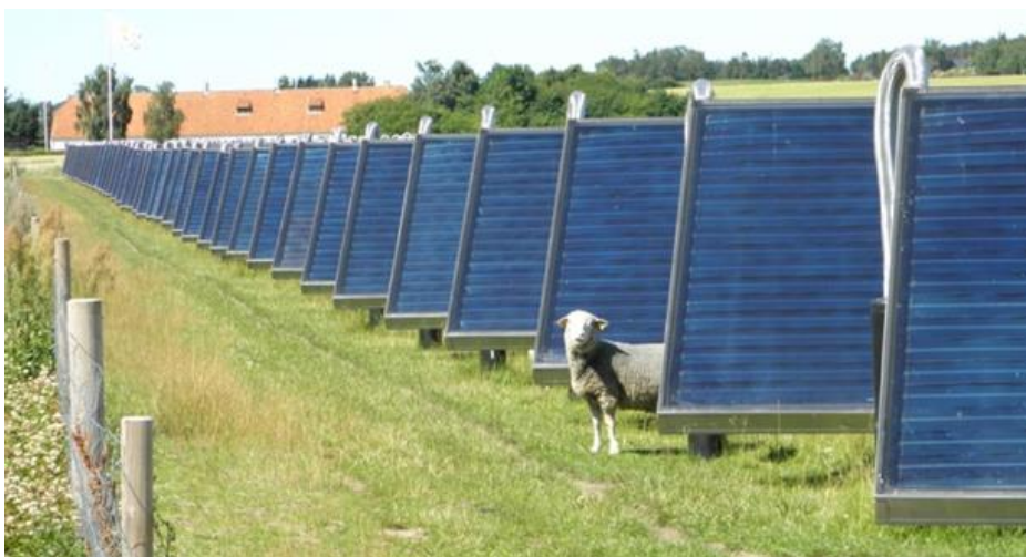
Solvarmeanlæg opsat af Jægerspris Kraftvarme.
